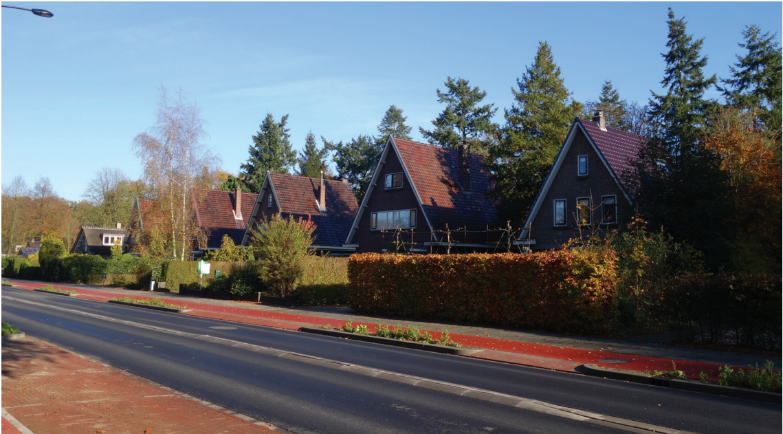
Figuur 6.4. Karakteristieke lintbebouwing langs de Harderwijkerstraat (foto: MAB).
